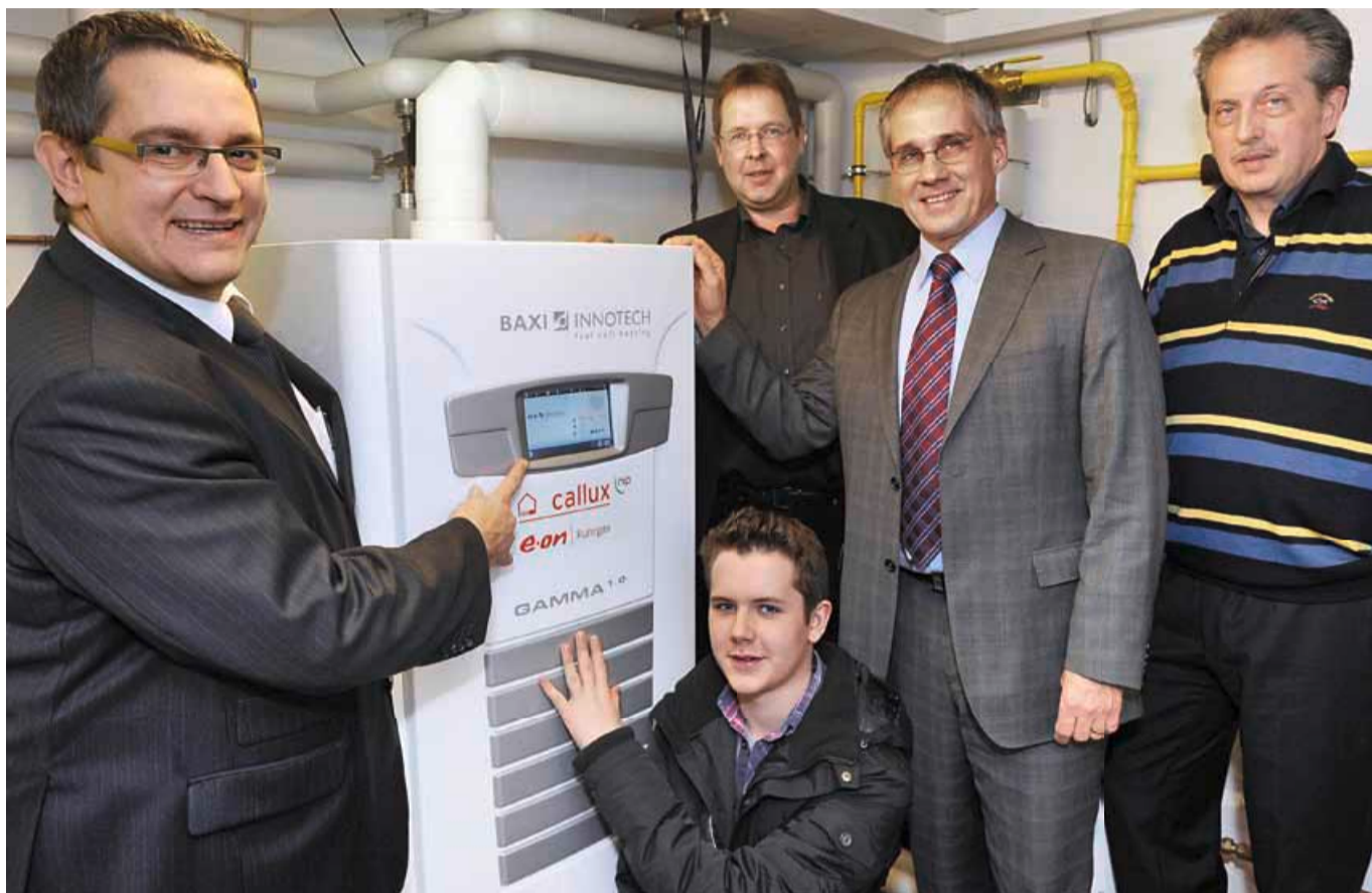
Stadtwerke-Geschäftsführer Kersten Kerl (l.) präsentiert die innovative Brennstoffzellen-Heizung. Bürgermeister Frank Schneider (2.v.r.) begrüßt das Zukunftsprojekt in einem Langenfelder Zweifamilienhaus. Installateur Markus Budzello (hinten, mit Sohn Jannis, vorn) konnte praktische Erfahrungen mit der Technologie sammeln. Hauseigentümer und Innenarchitekt Georg Heller (r.) ist zufrieden mit der effizienten Anlage.
